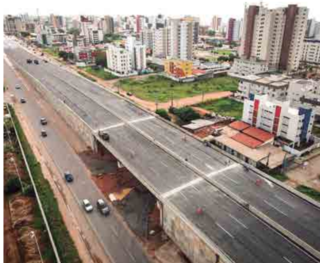
Participaram das obras 145 militares do Exército, que utilizaram 55 viaturas e 60 equipamentos de engenharia
