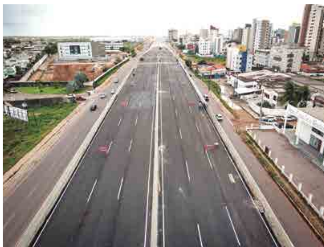
Novos viadutos fazem parte do projeto de ampliação da estrutura da BR-230 na Região Metropolitana de João Pessoa
